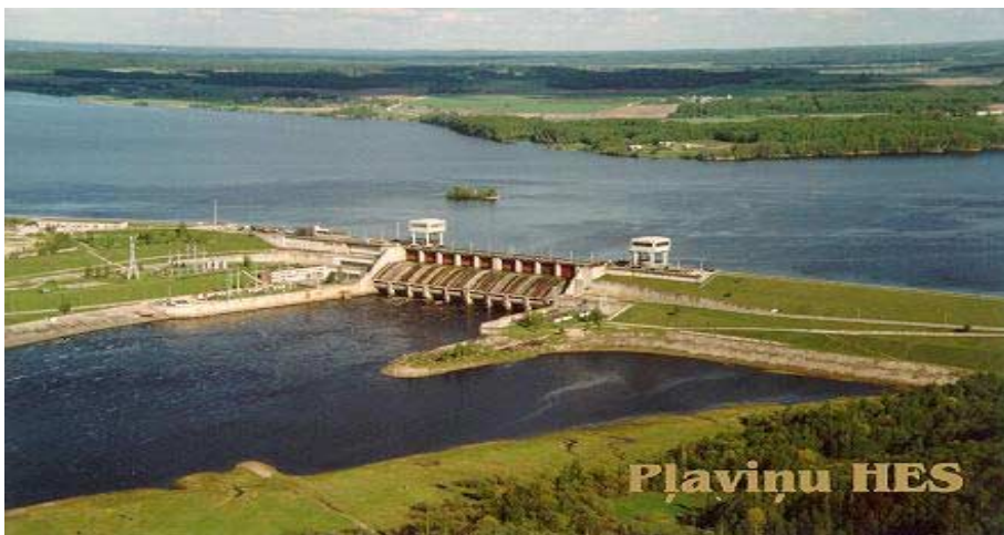
Barrage de Plavinas (70 m de hauteur) : La principale station hydroélectrique de Lettonie
